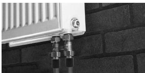
Непосредственное подключение трубы к радиатору через H-образную гарнитуру
